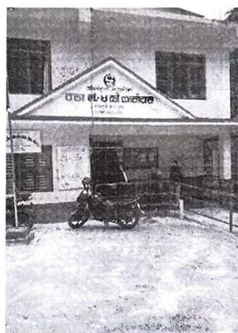
वडा कार्यालय भवन
